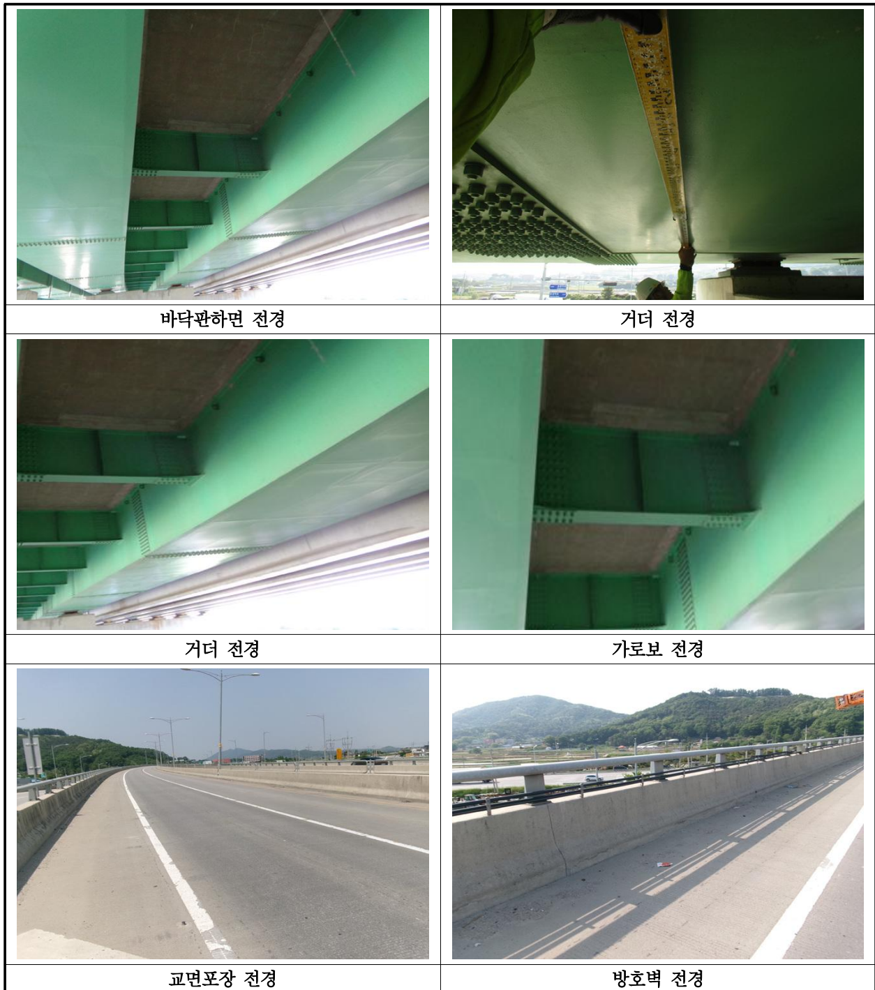
【사진 4.2.2】 상부구조 현황
