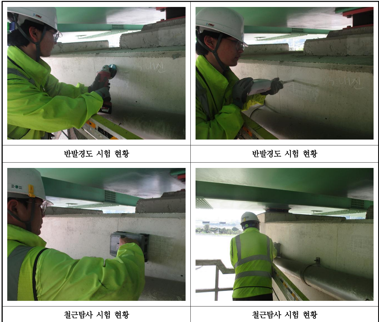
【사진 4.3.1】 콘크리트 내구성조사 현황
