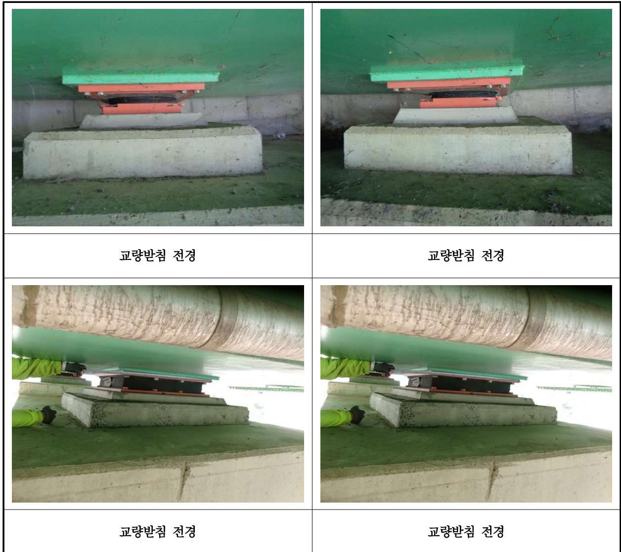
【사진 4.2.5】 교량받침 현황
